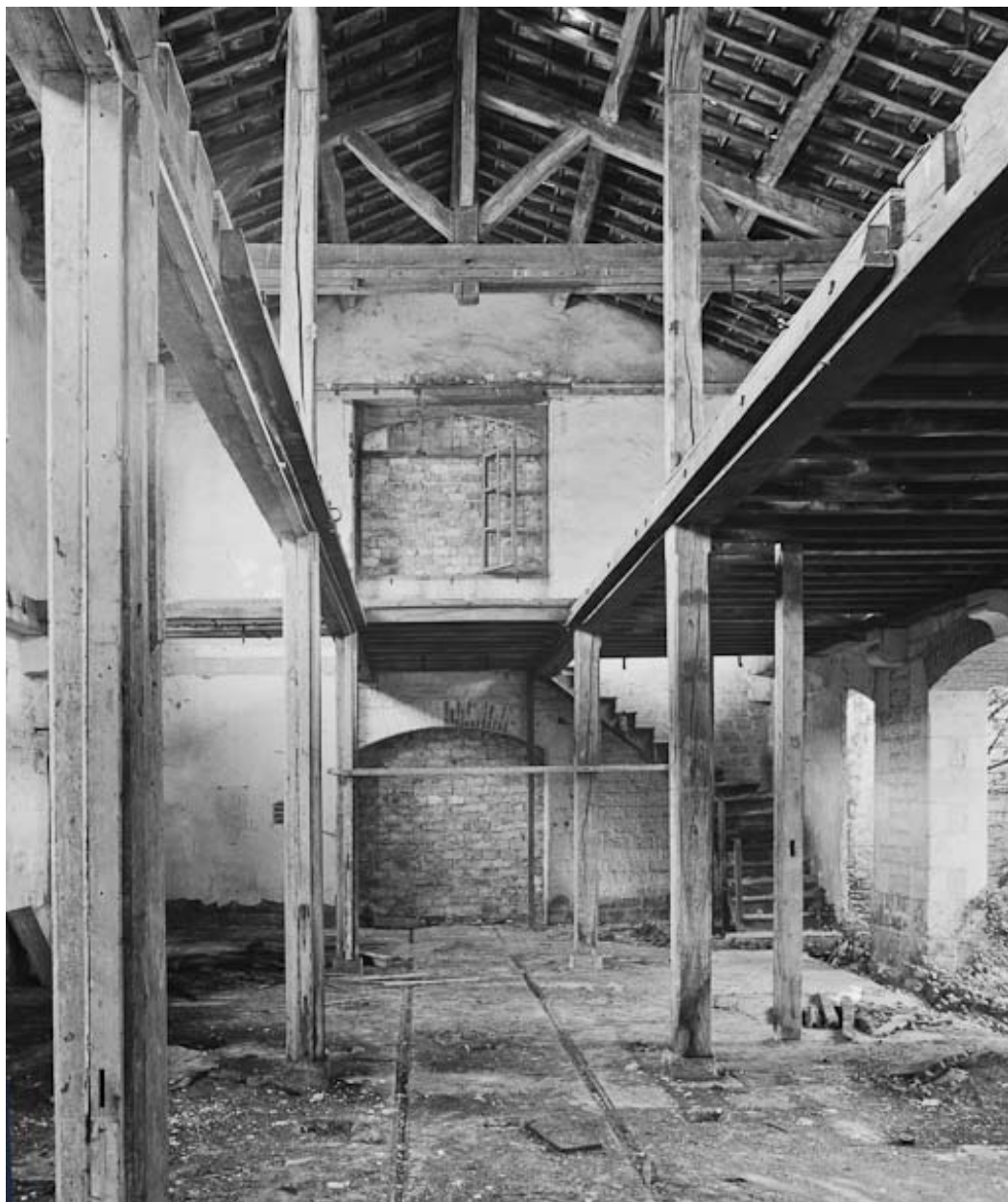
État en 1984, vue intérieure.
