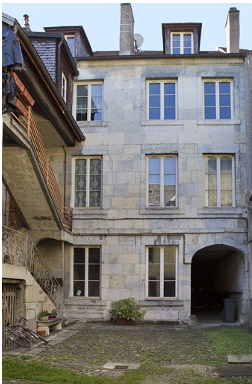
Façade postérieure du logis principal.
