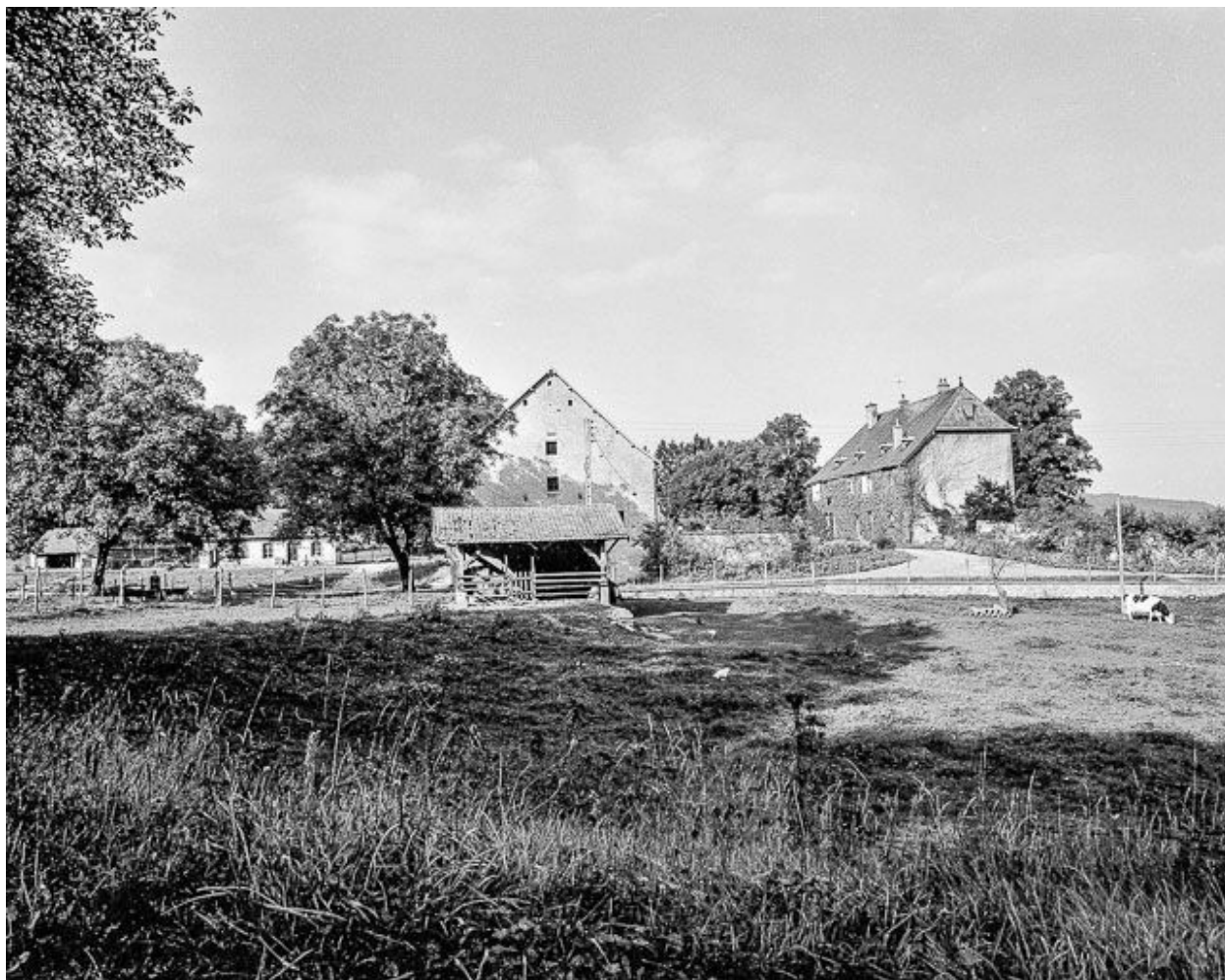
Vue d'ensemble des bâtiments de ferme et de l'habitation en 1980.
