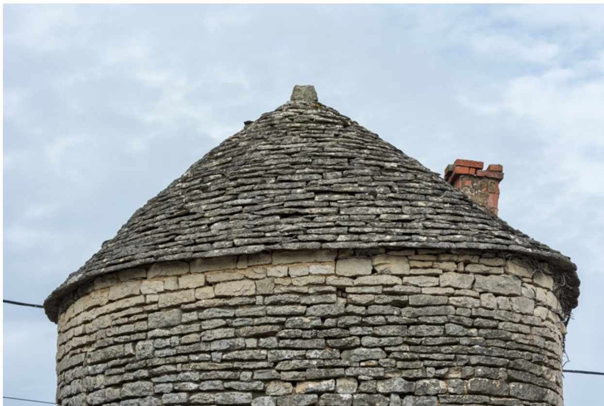
Détail de la toiture.
