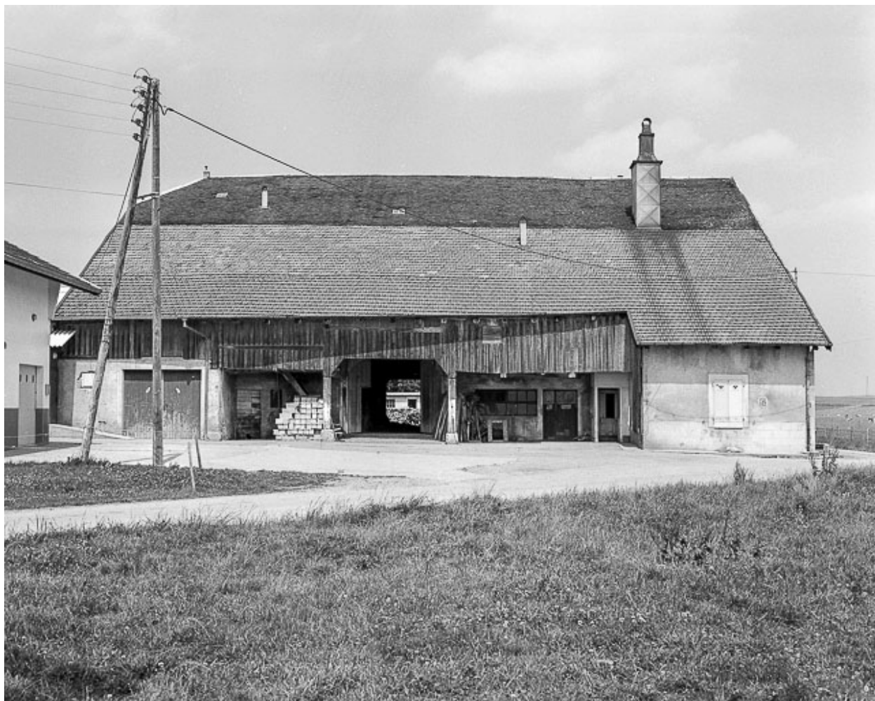
Façade latérale droite d'une ferme.
