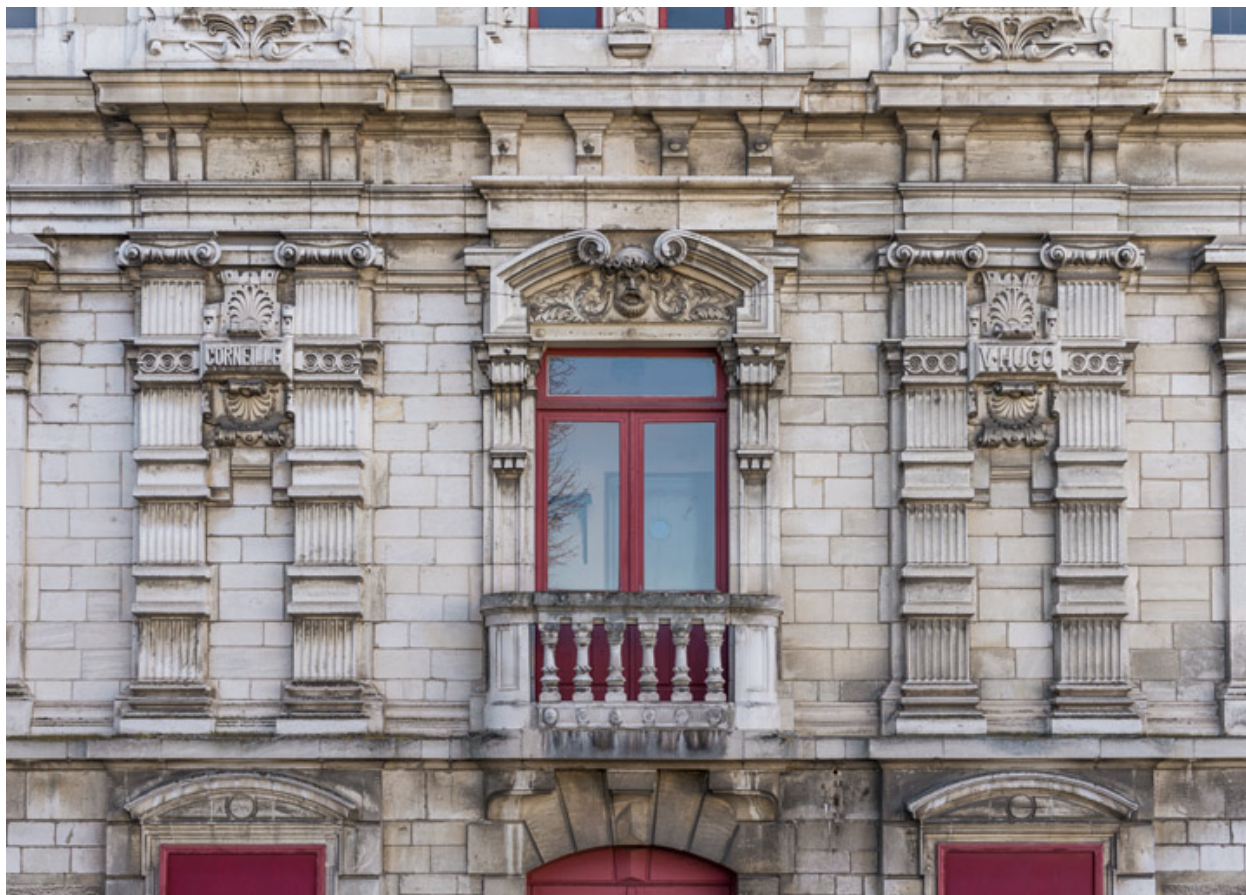
Façade latérale gauche : étage carré.
