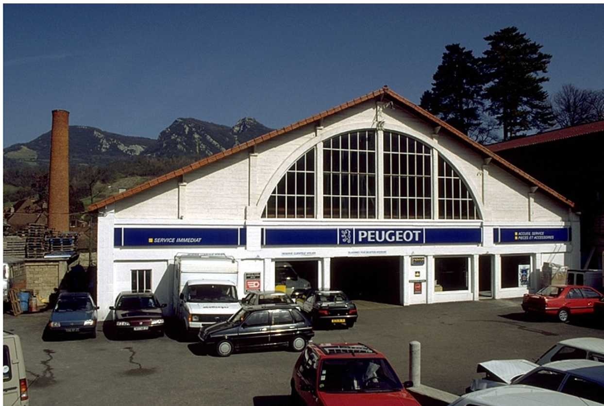
Pignon sud de l'atelier de fabrication.
