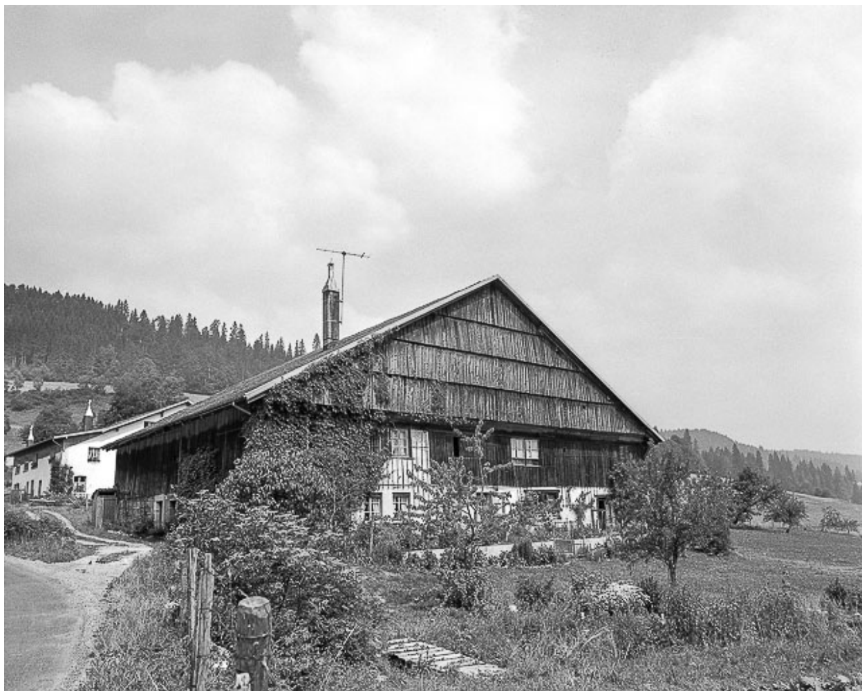
Façade antérieure, de trois quarts gauche, en 1976.
