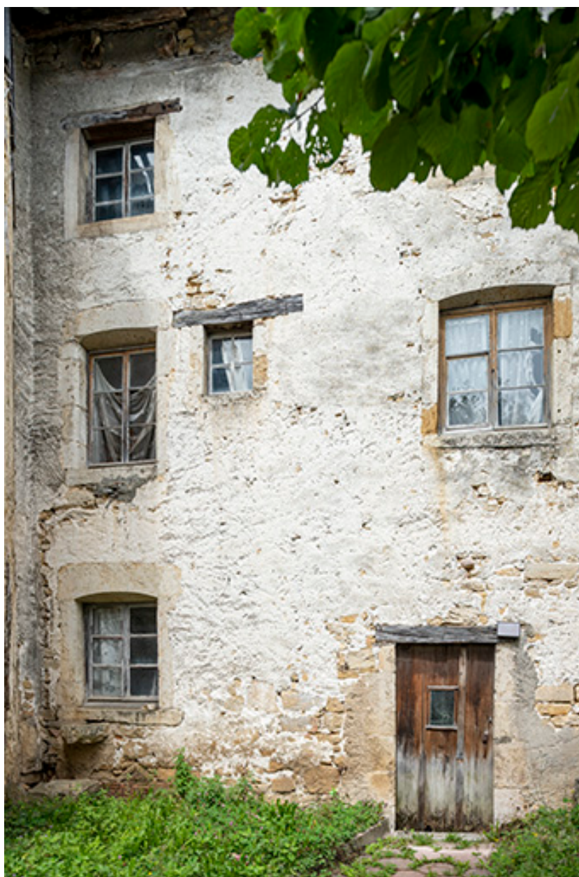
Maison : façade postérieure, de trois quarts.
