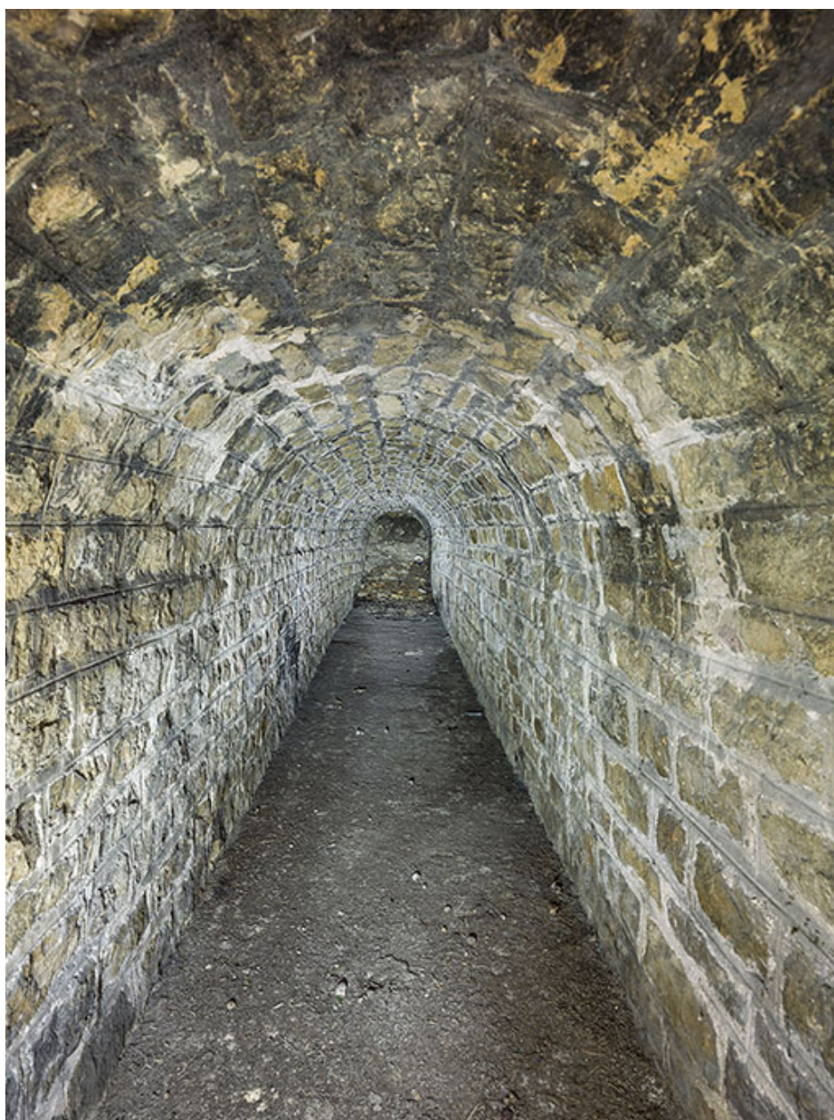
Galerie de la poterne (face).
