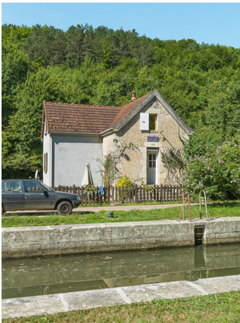
Vue de la maison éclusière.
