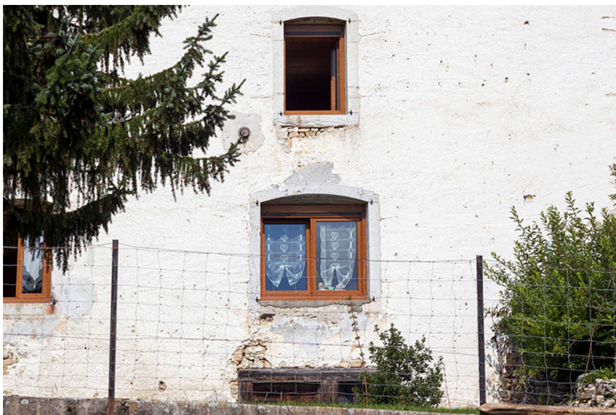
Façade est : fenêtres.
