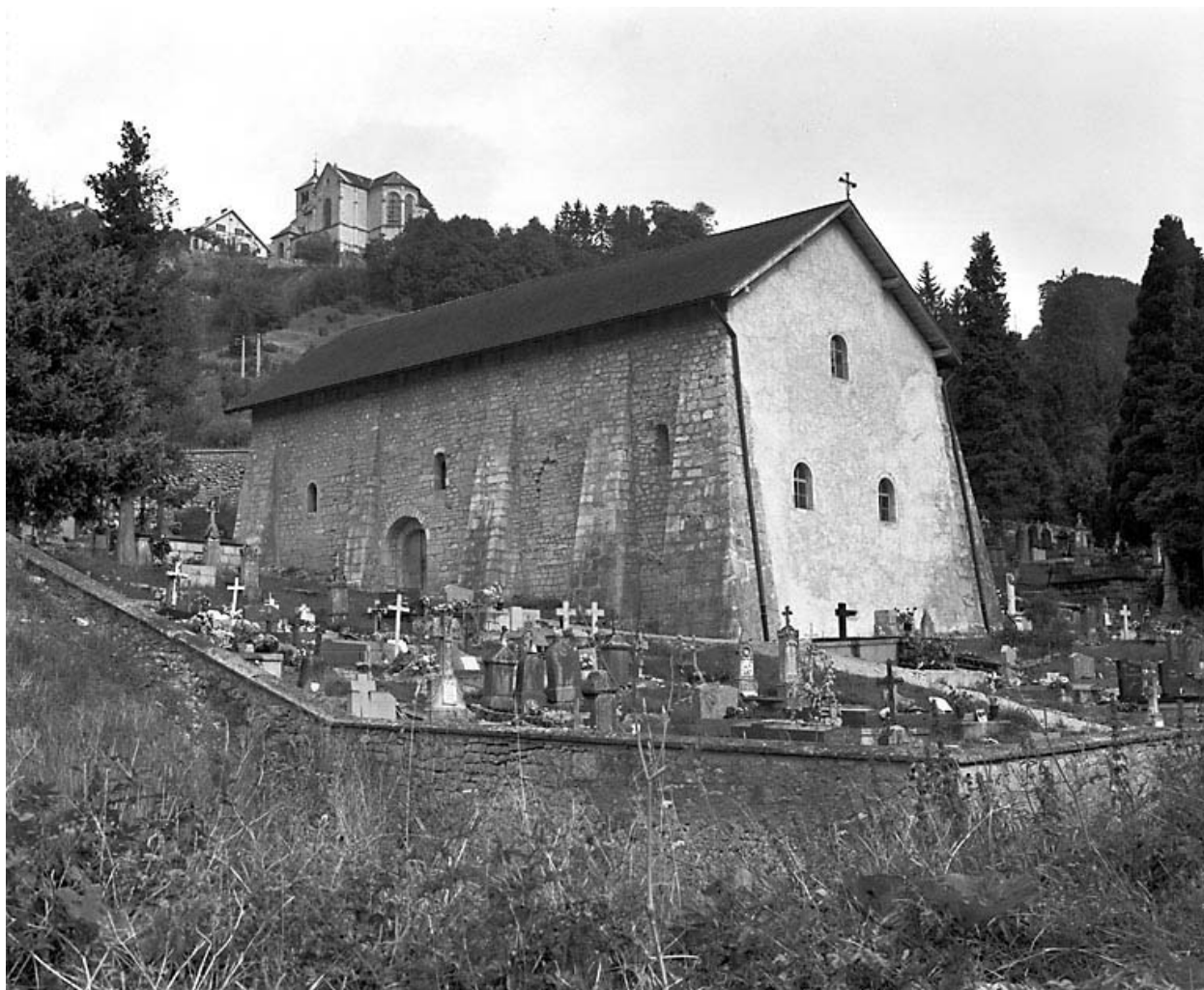
Façades sud et est.
