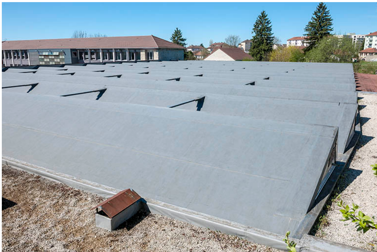
Atelier, site Edouard Herriot, toiture en sheds.
