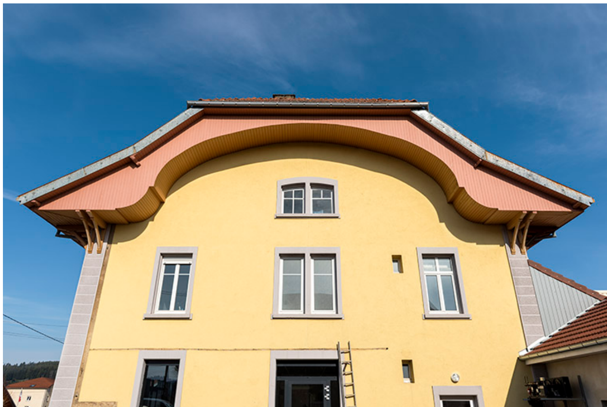
Façade latérale droite, vue en contre-plongée.
