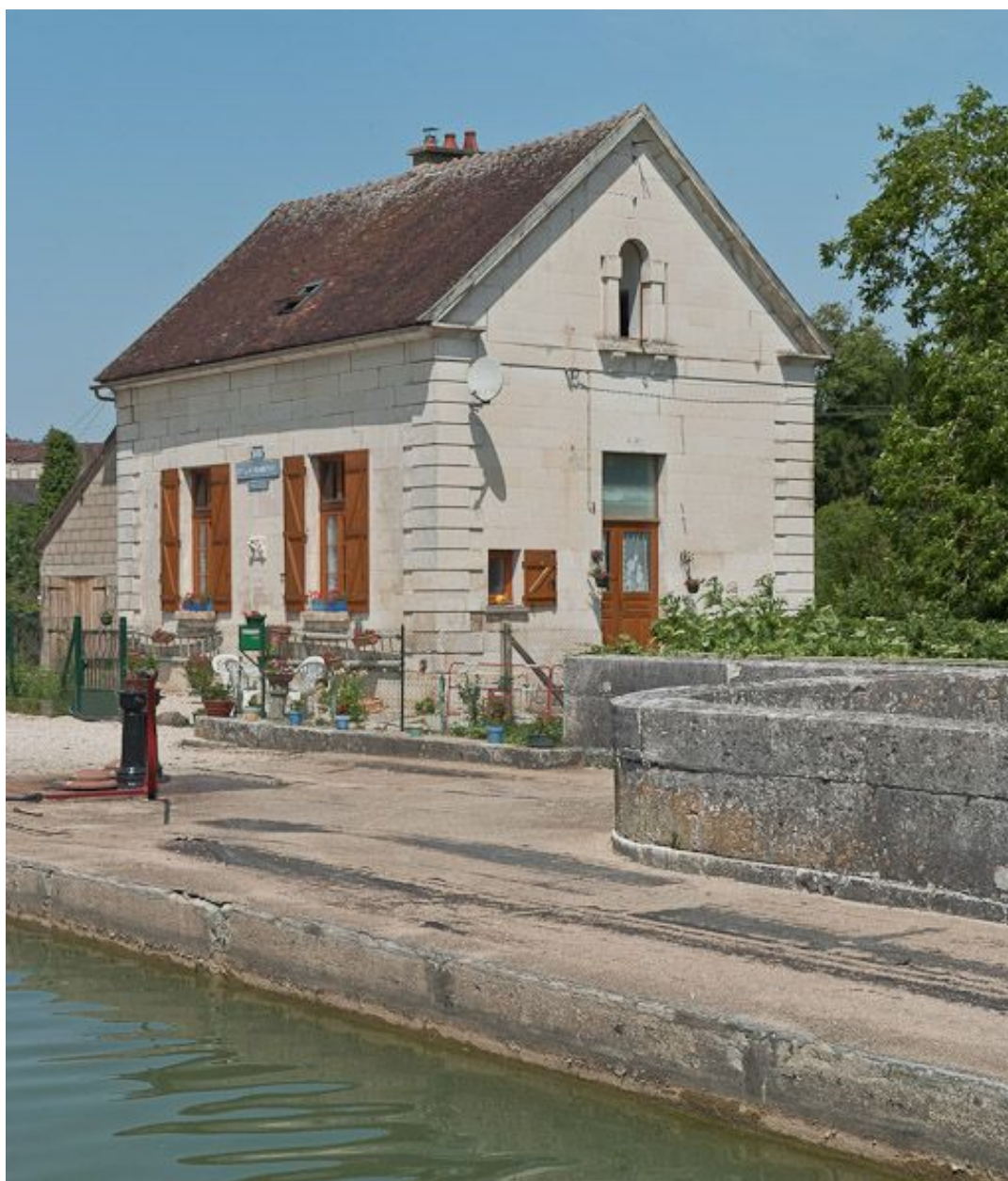
Vue de la maison éclusière.
