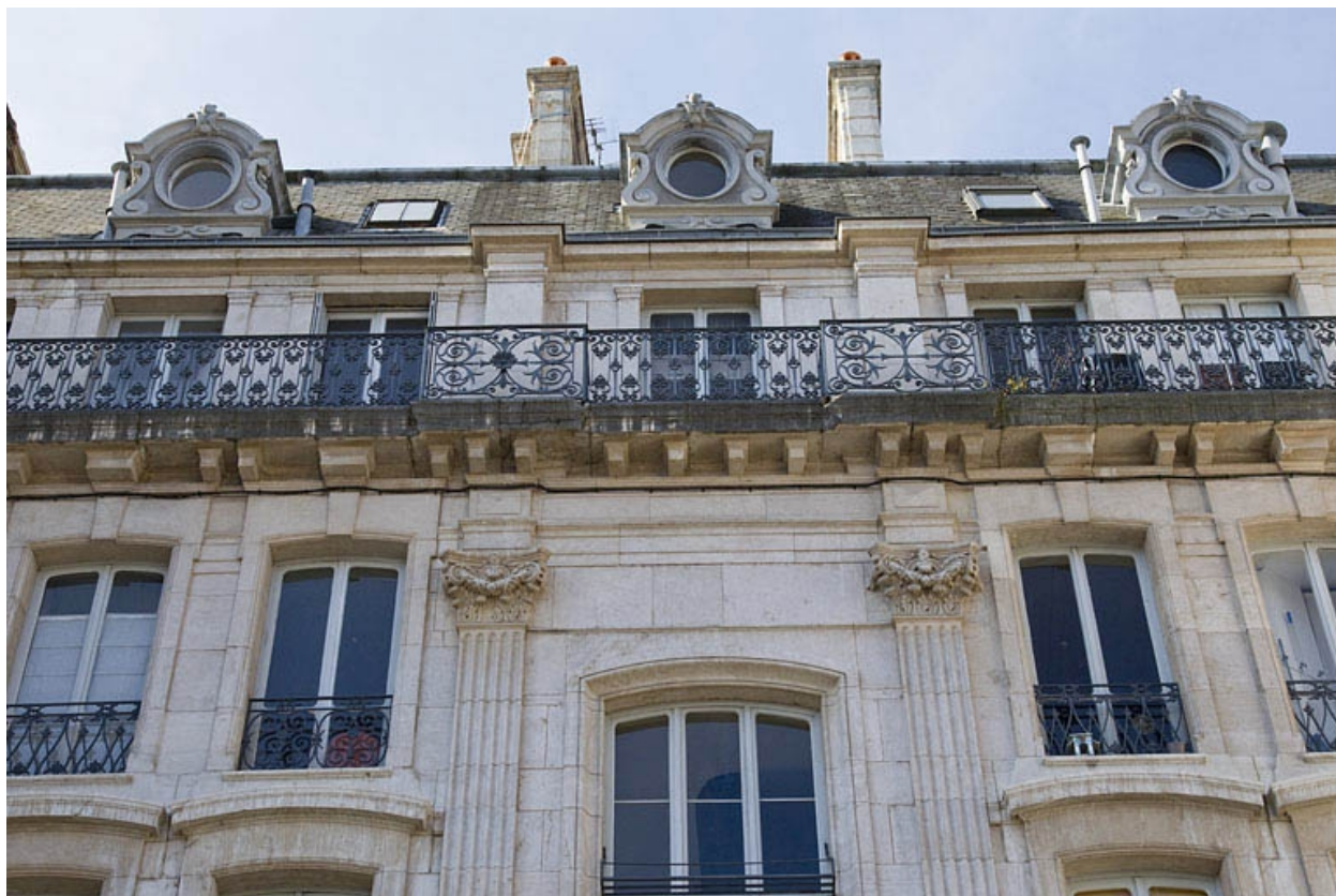
Façade antérieure : détail de la partie supérieure.
