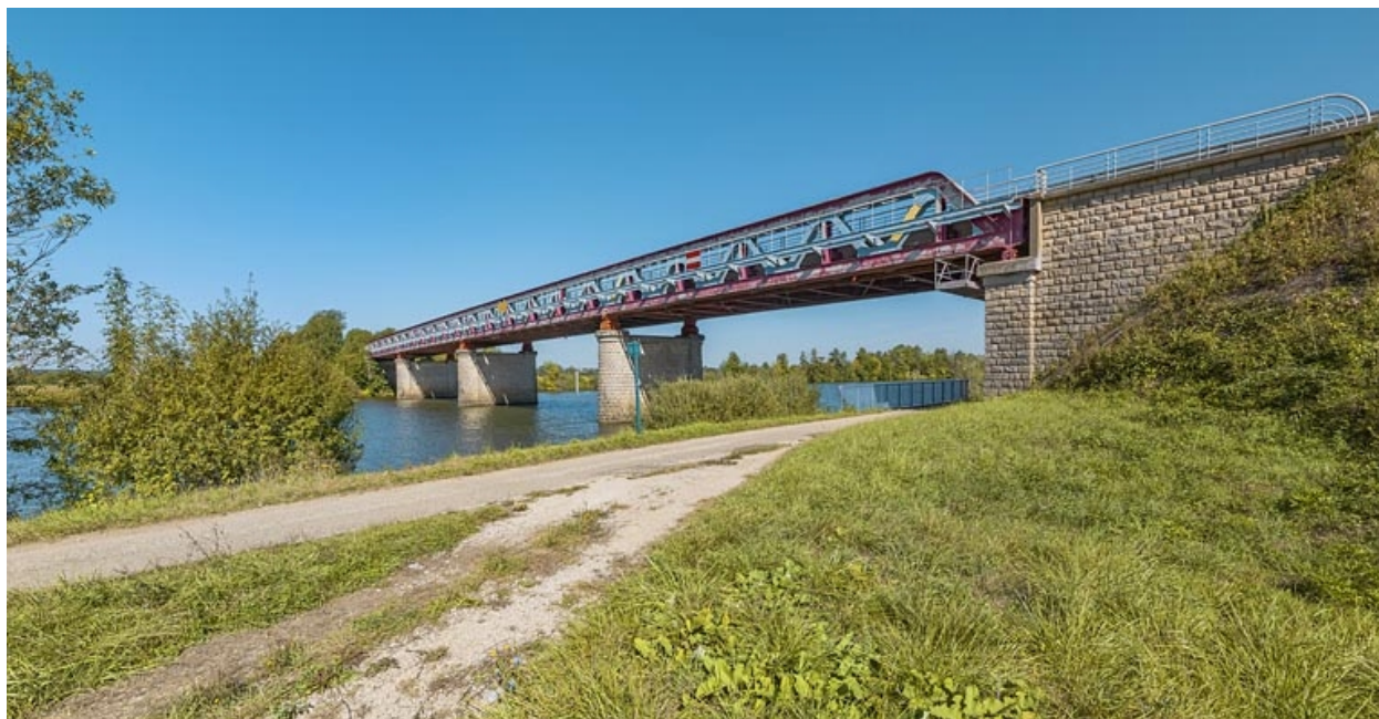
Vue d'ensemble du pont.
