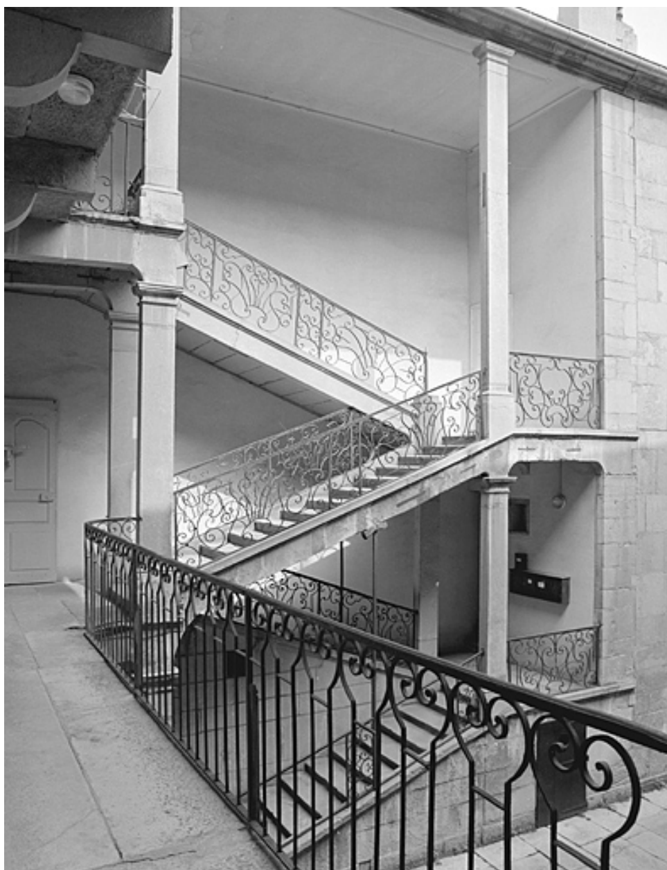
Escalier dans la cour.
