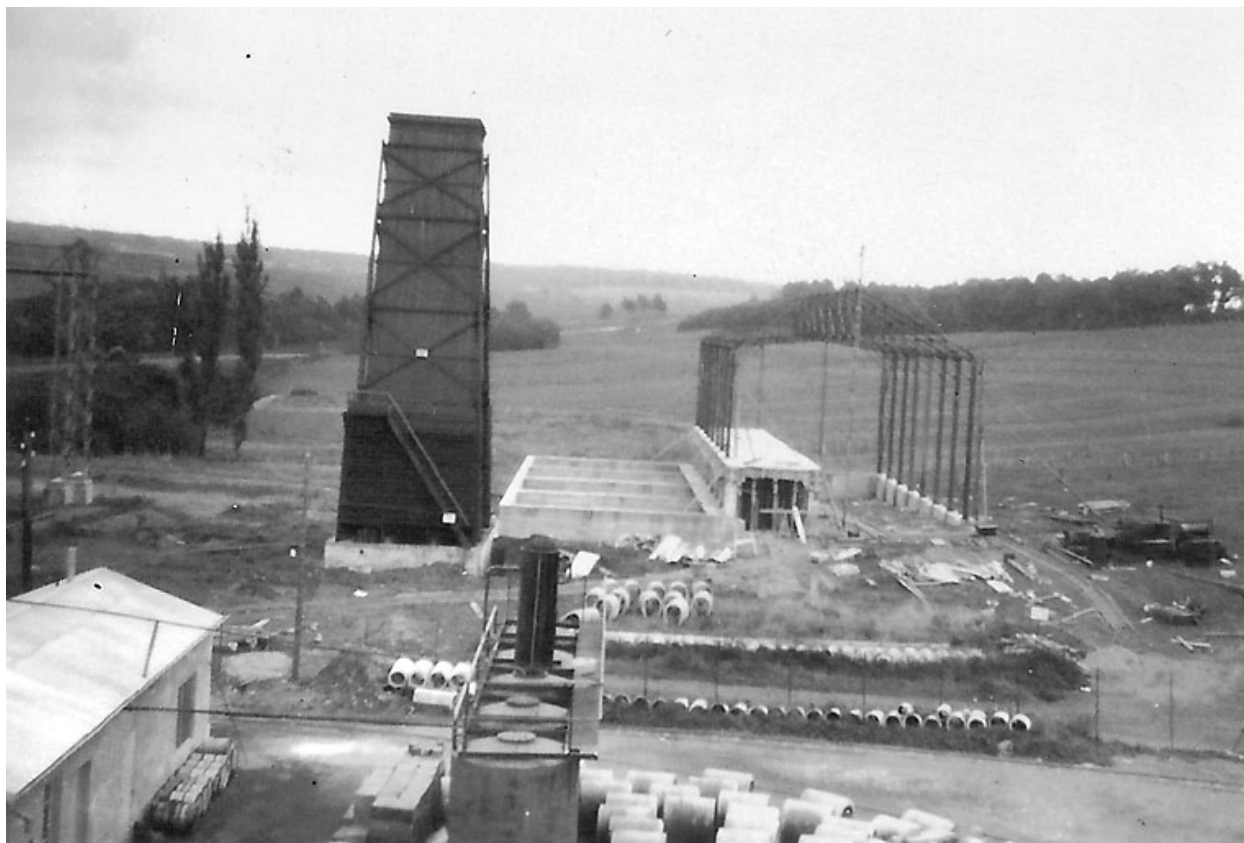
Tour de réfrigération et raffinerie en construction.
