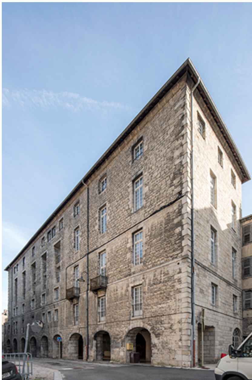
Elévation sur rue depuis le sud-ouest.
