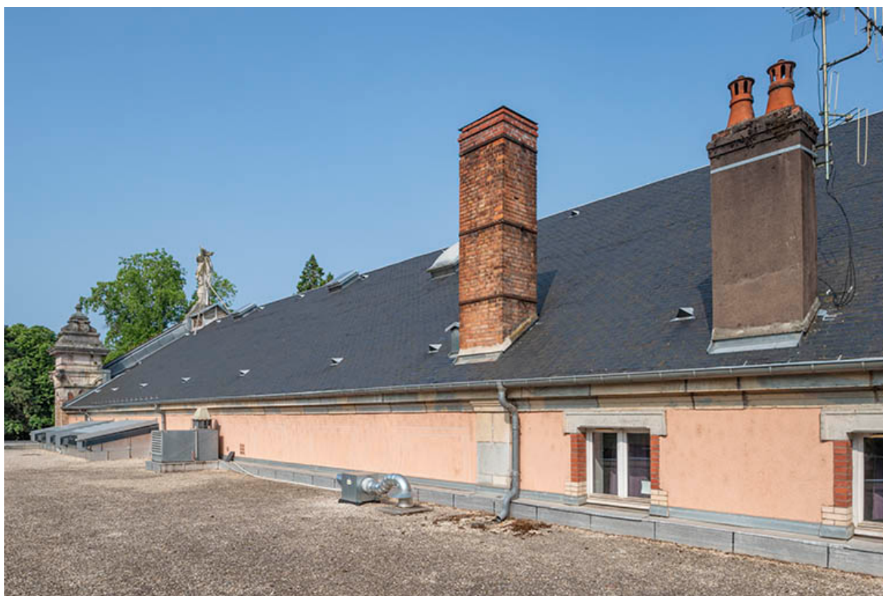
Toiture, vue depuis l'est.
