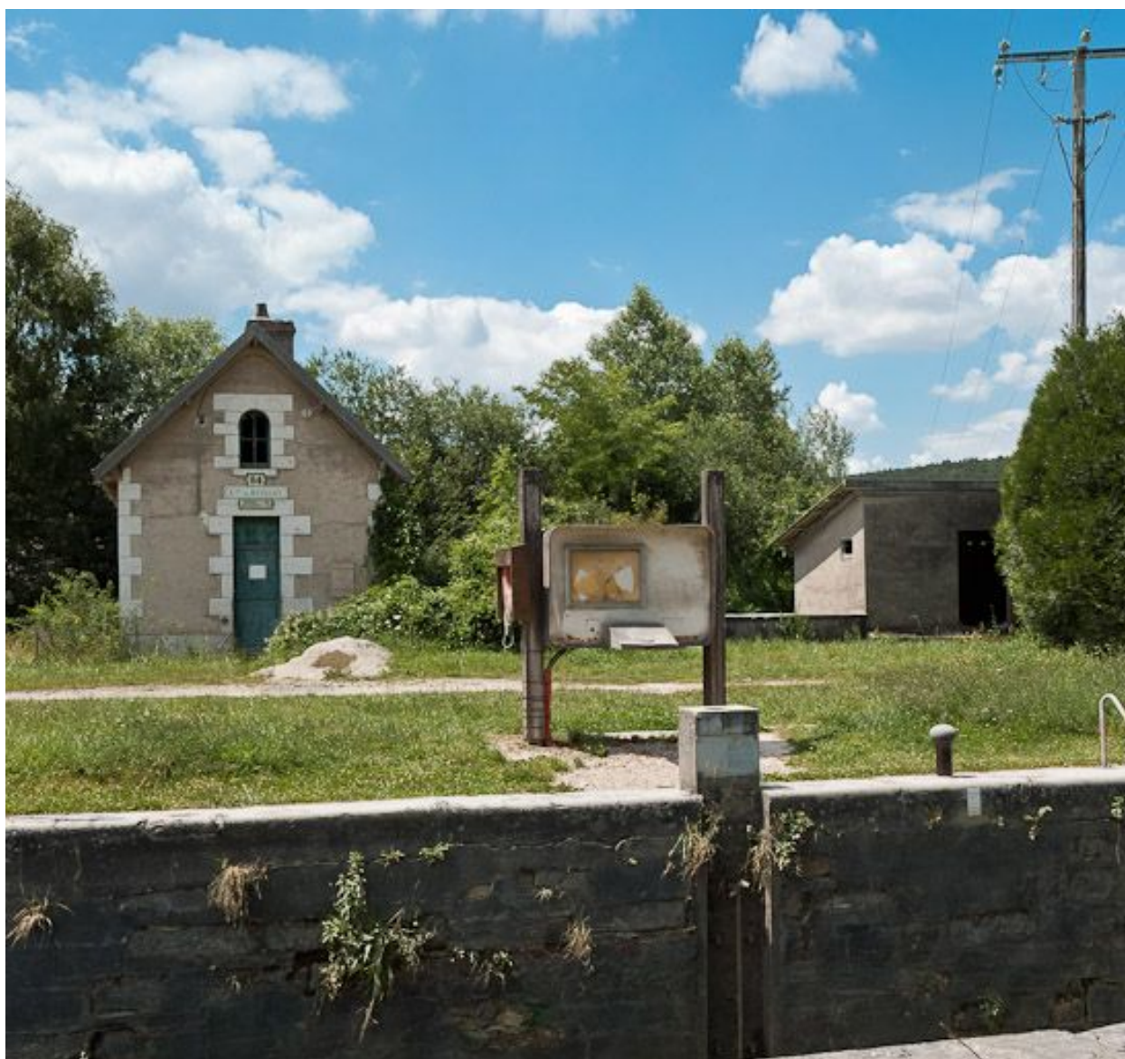
Vue d'ensemble du site d'écluse.
