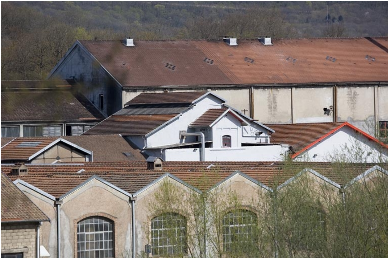
Vue rapprochée des couvertures depuis le sud.
