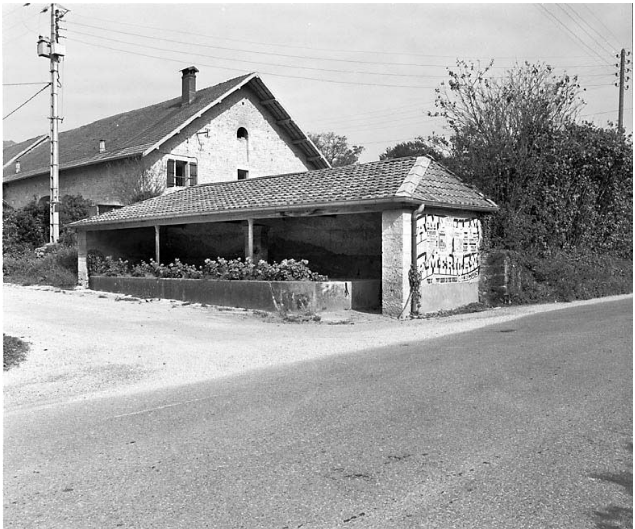
Fontaine-lavoir située à l'angle de la rue des Vignes et de la rue du Général Broissia.
