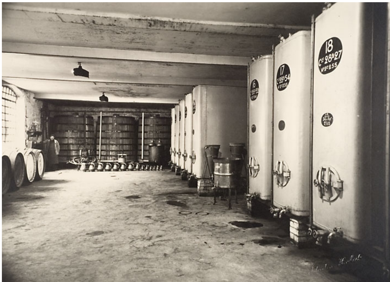
Intérieur de la cuverie.
