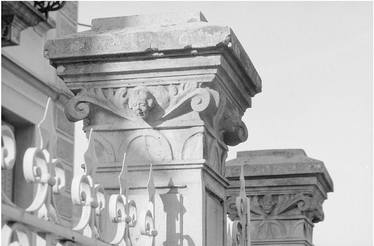
Chapiteau des piliers du portail d'entrée.
