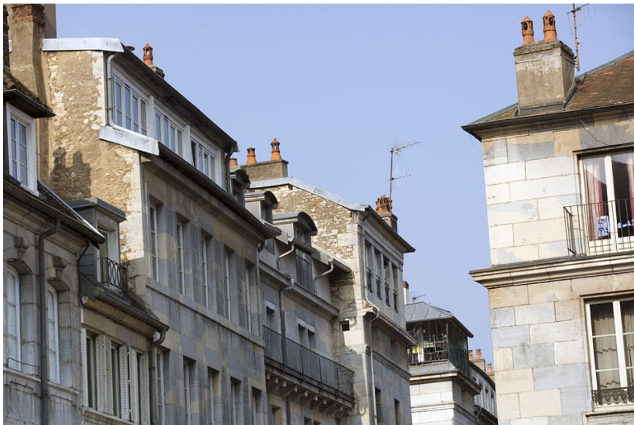
Partie supérieure de la façade sur rue.
