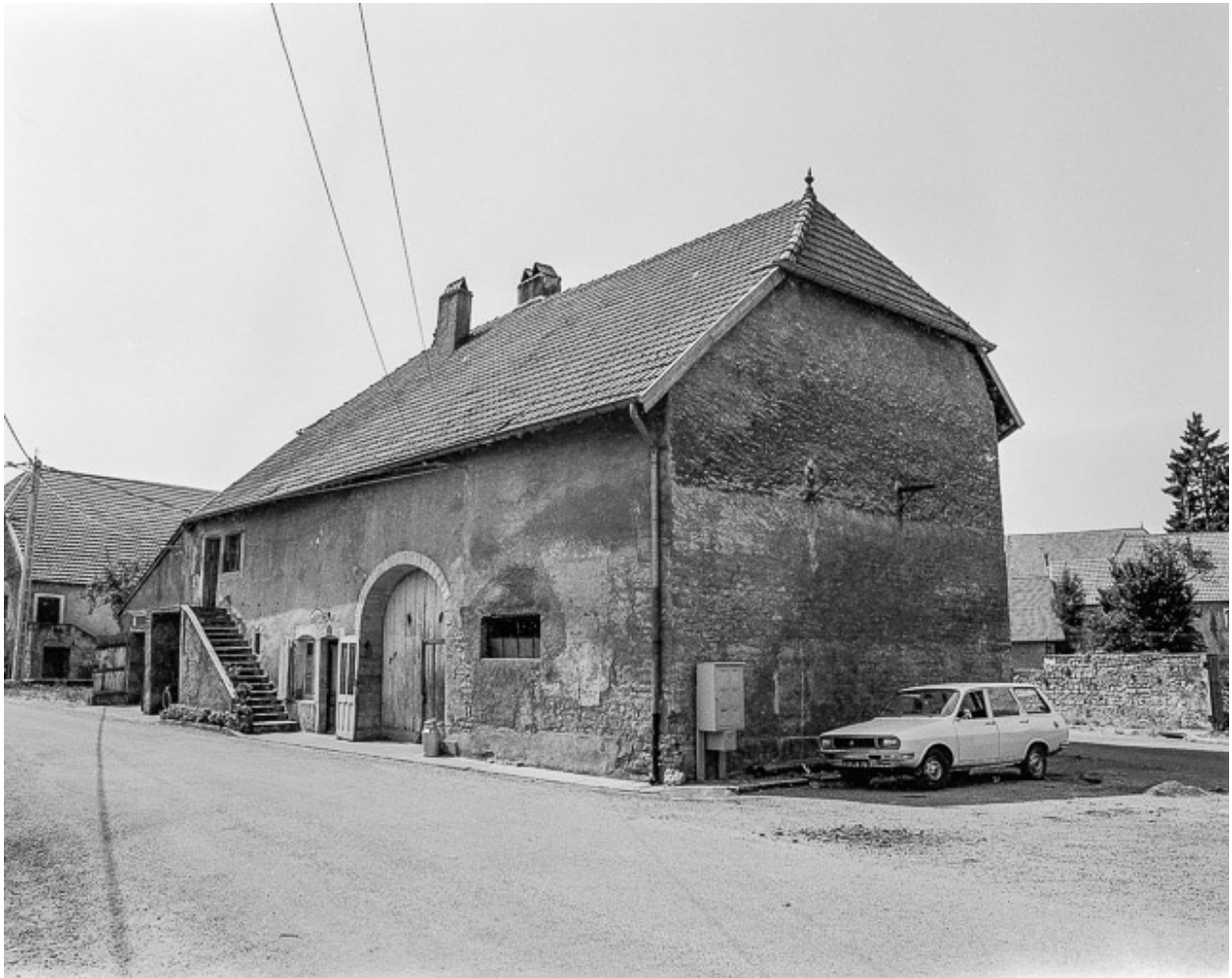
Ferme située entre la rue d'Amont et la rue de la Fontaine : façade antérieure et façade latérale droite.
