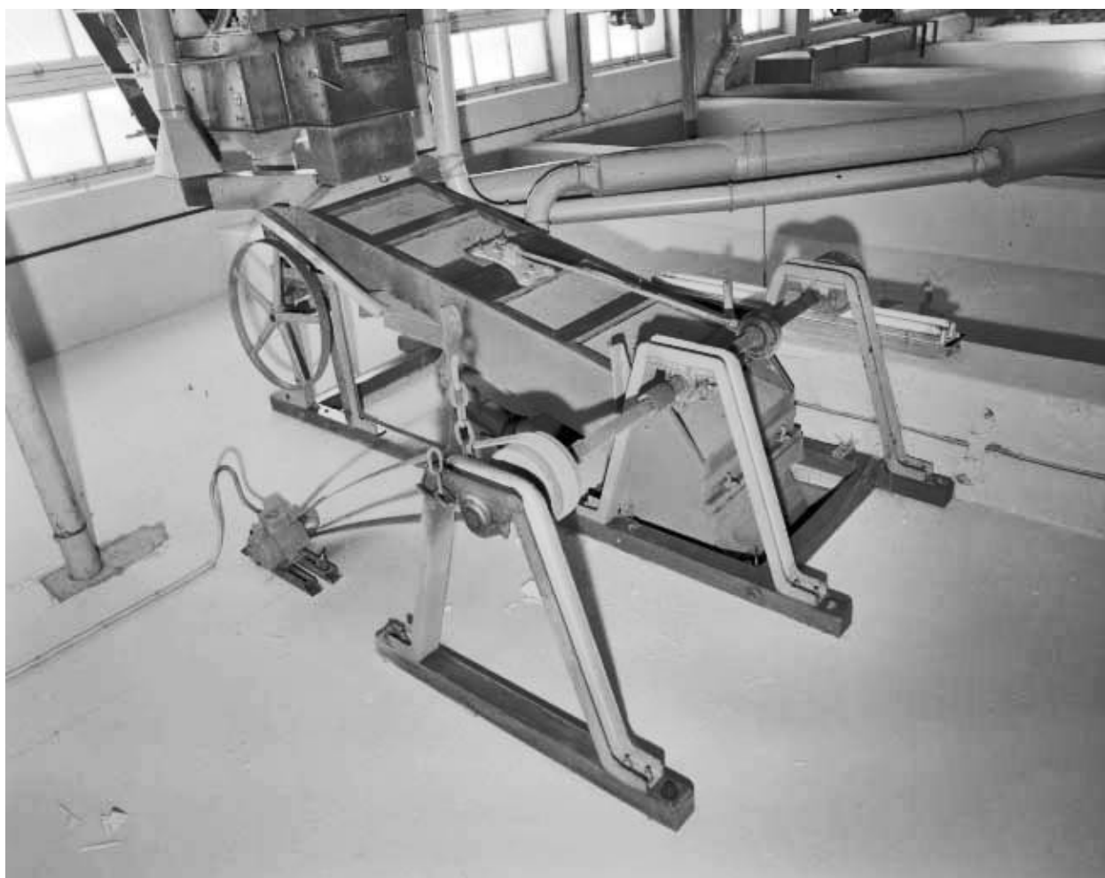
Trémie d'alimentation et distributeur vibrant.
