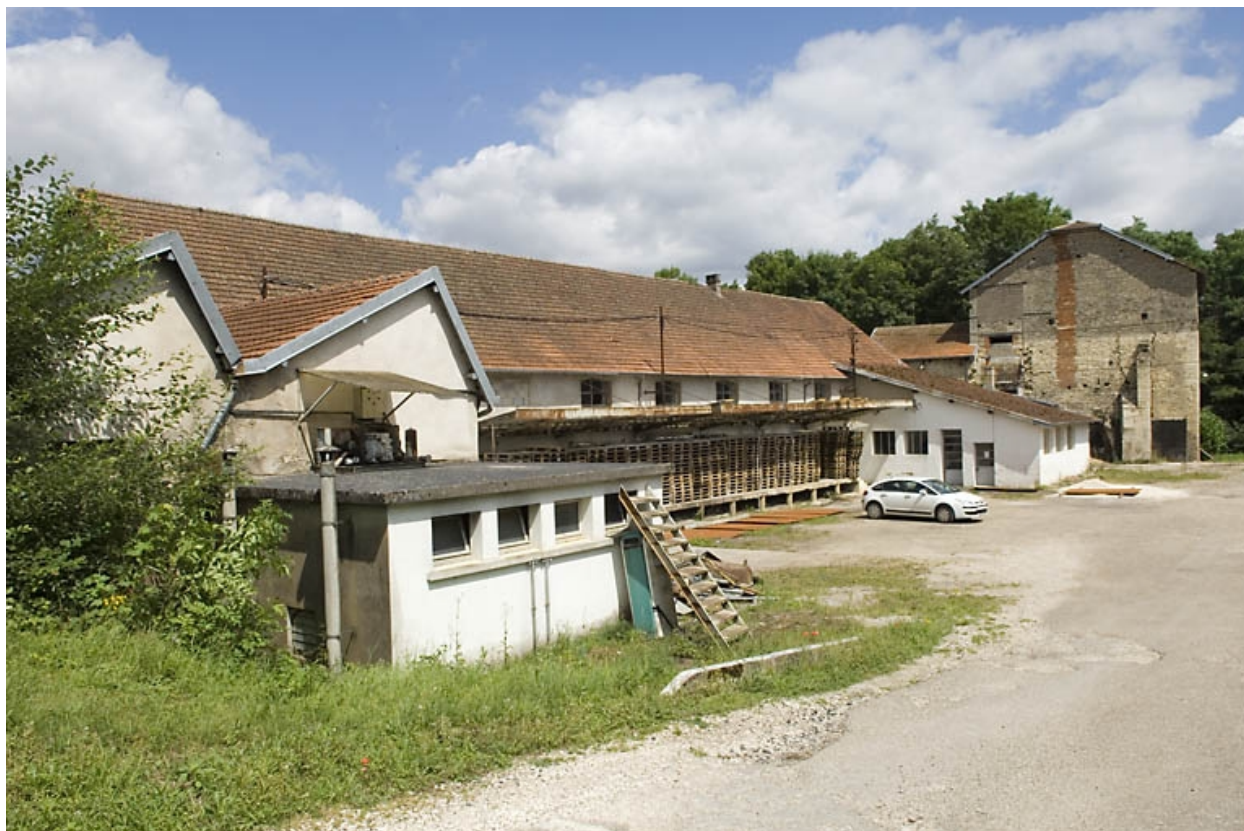
Vue d'ensemble depuis l'entrée du site.
