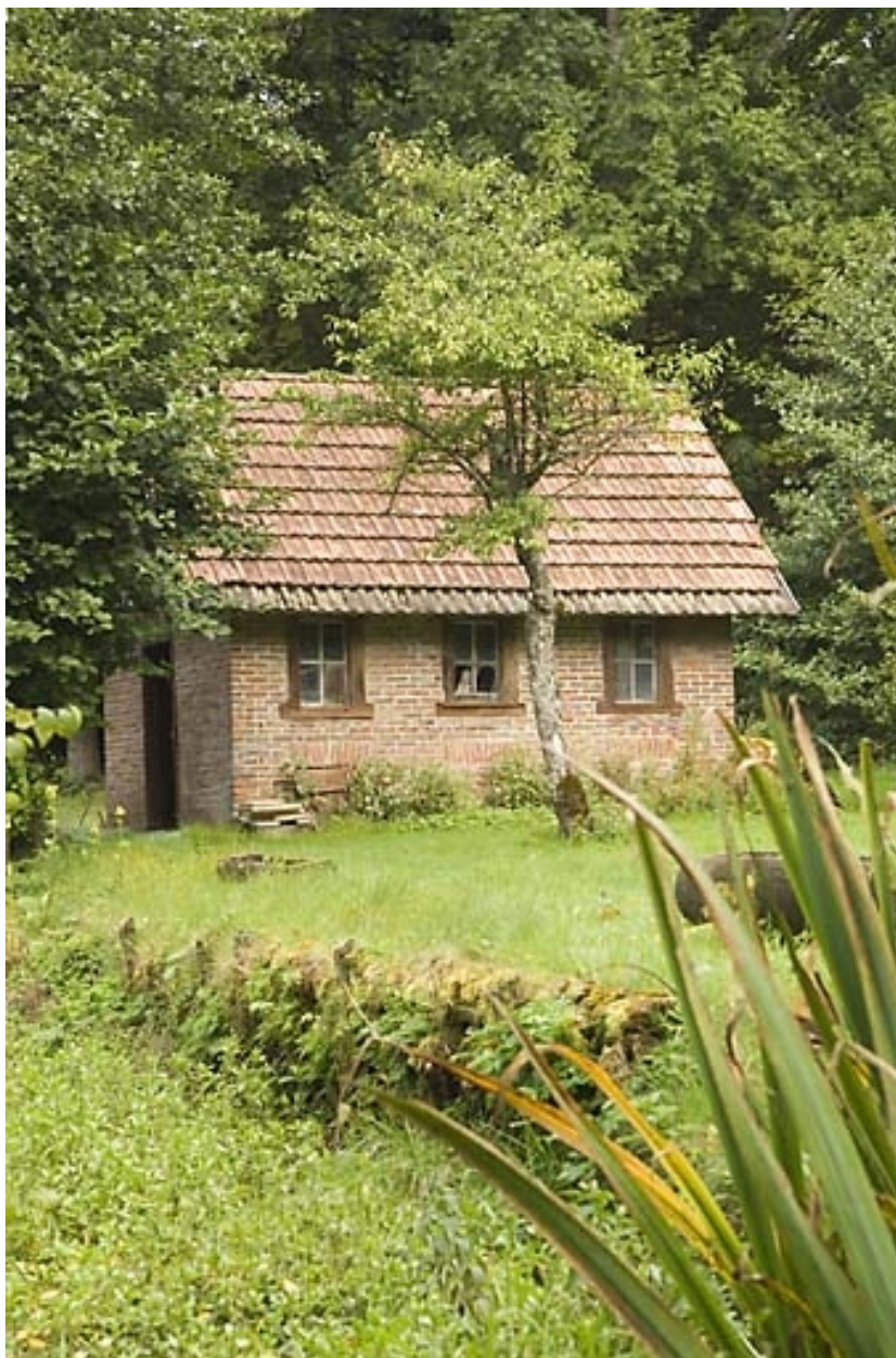
Remise : vue d'ensemble, depuis le sud.
