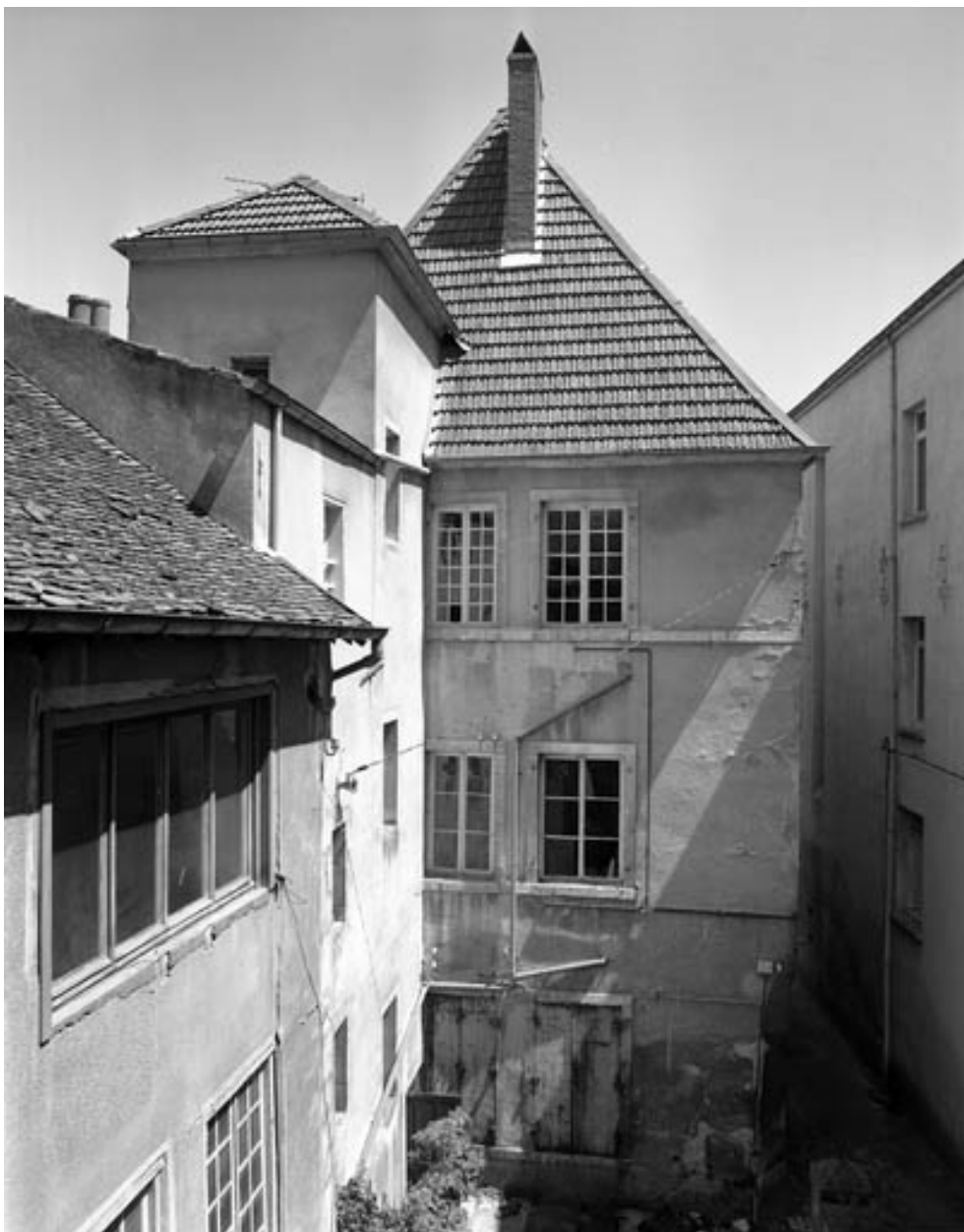
Façade postérieure et aile sur cour.
