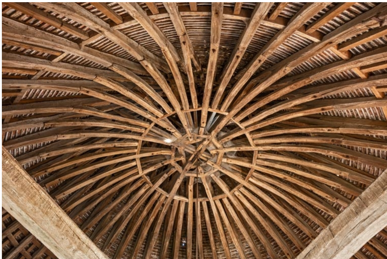
Tour Margot : charpente du 2e étage.
