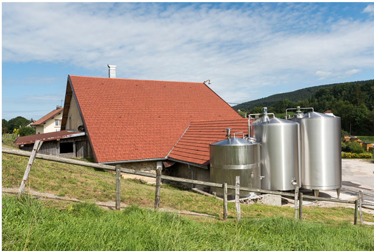
Façade latérale gauche.
