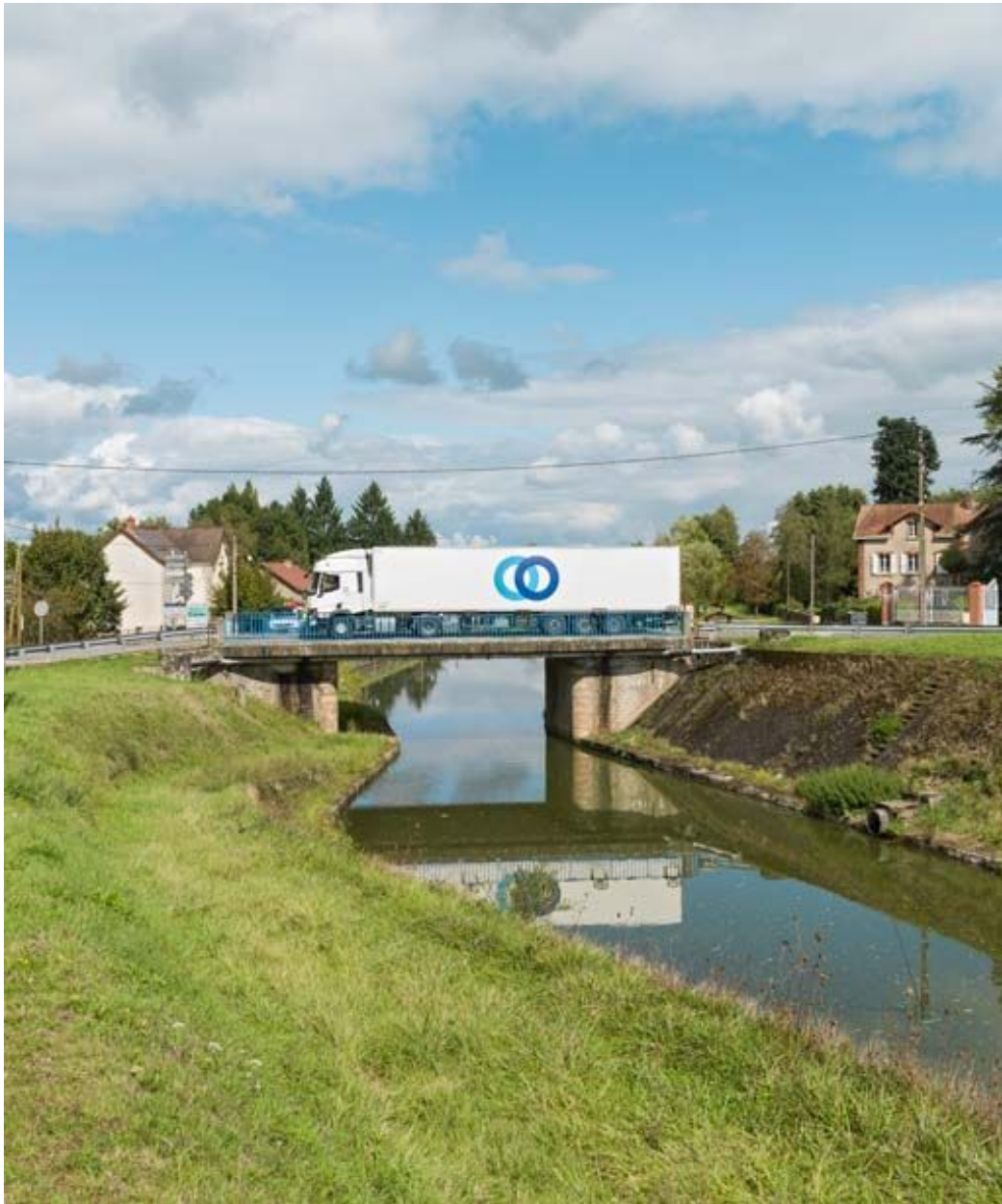
Vue d'ensemble du pont.
