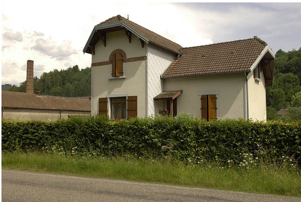
Logement de contremaître.
