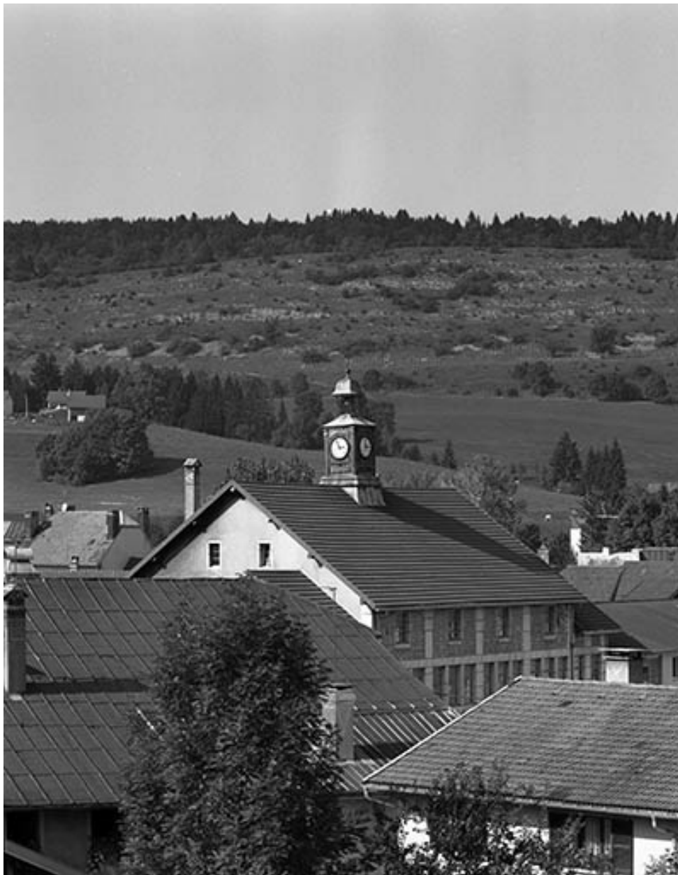
La toiture de l'usine depuis le sud-est.
