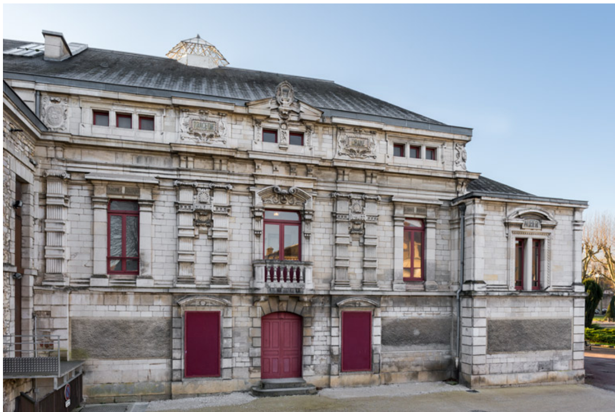
Façade latérale gauche : salle et vestibule.
