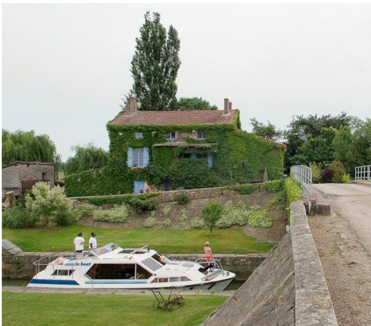
Le site d'écluse de La Truchère : le sas. A l'arrière-plan, la maison éclusière.
