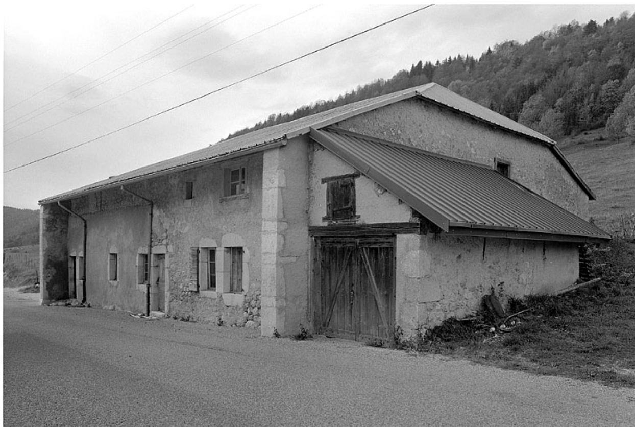
Façade antérieure et face nord-est.
