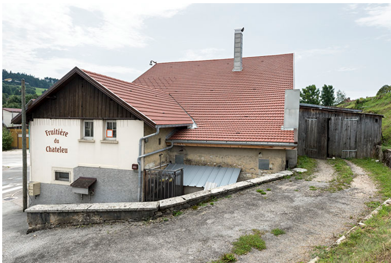
Façade latérale droite.
