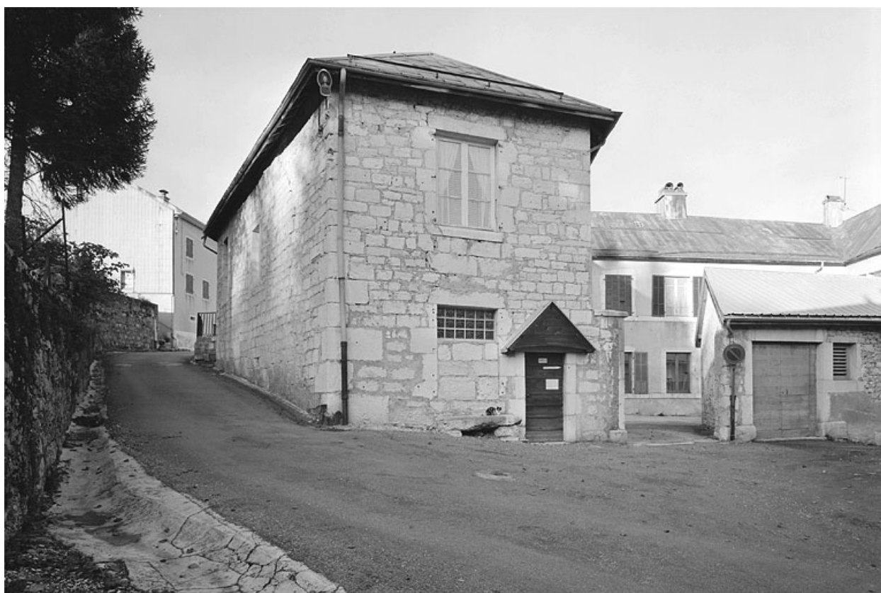
Vue générale, face sud-ouest.
