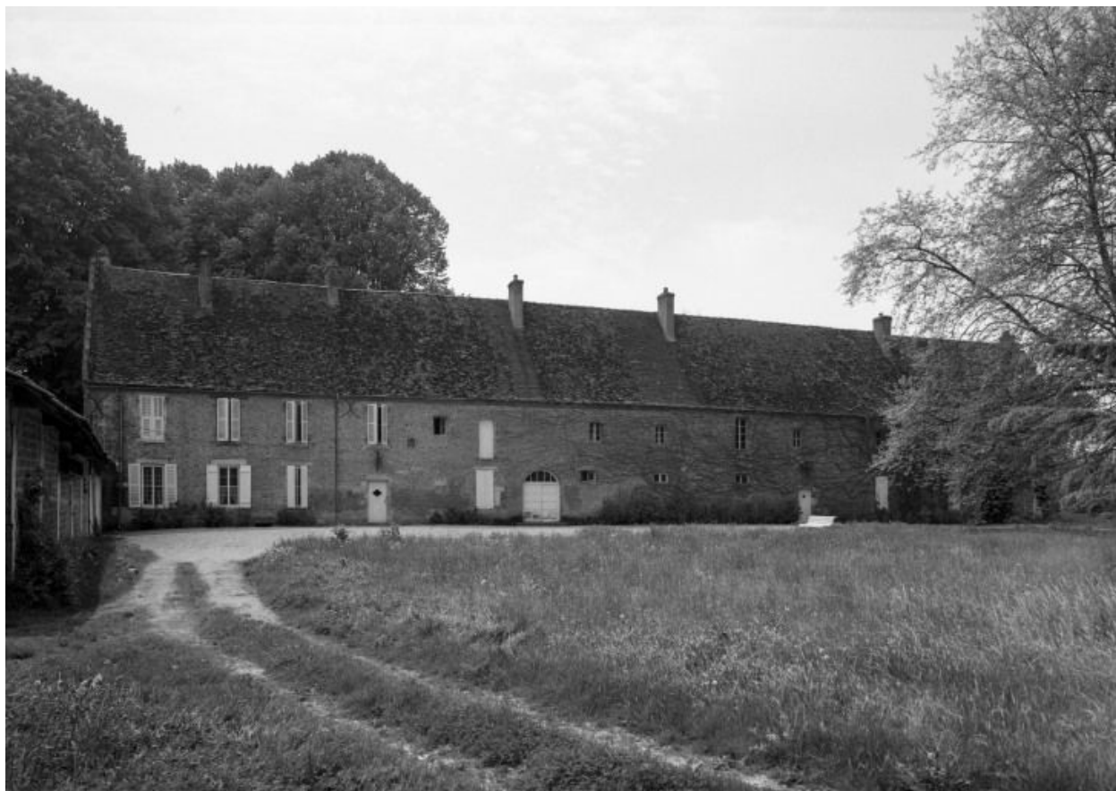
Bâtiment de l'ancien château, élévation sur cour.
