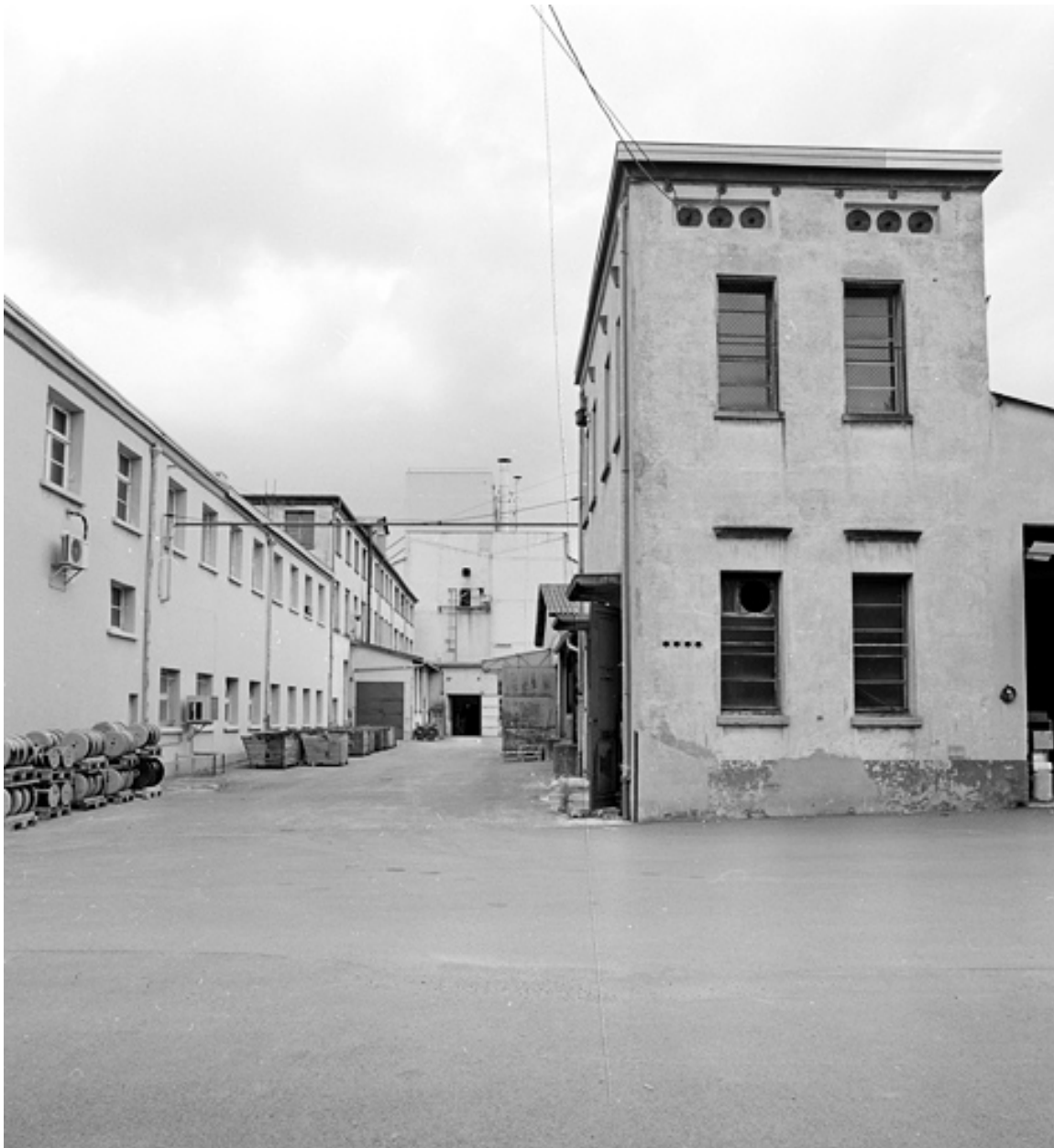
Bureau d'études (à gauche) et transformateur.
