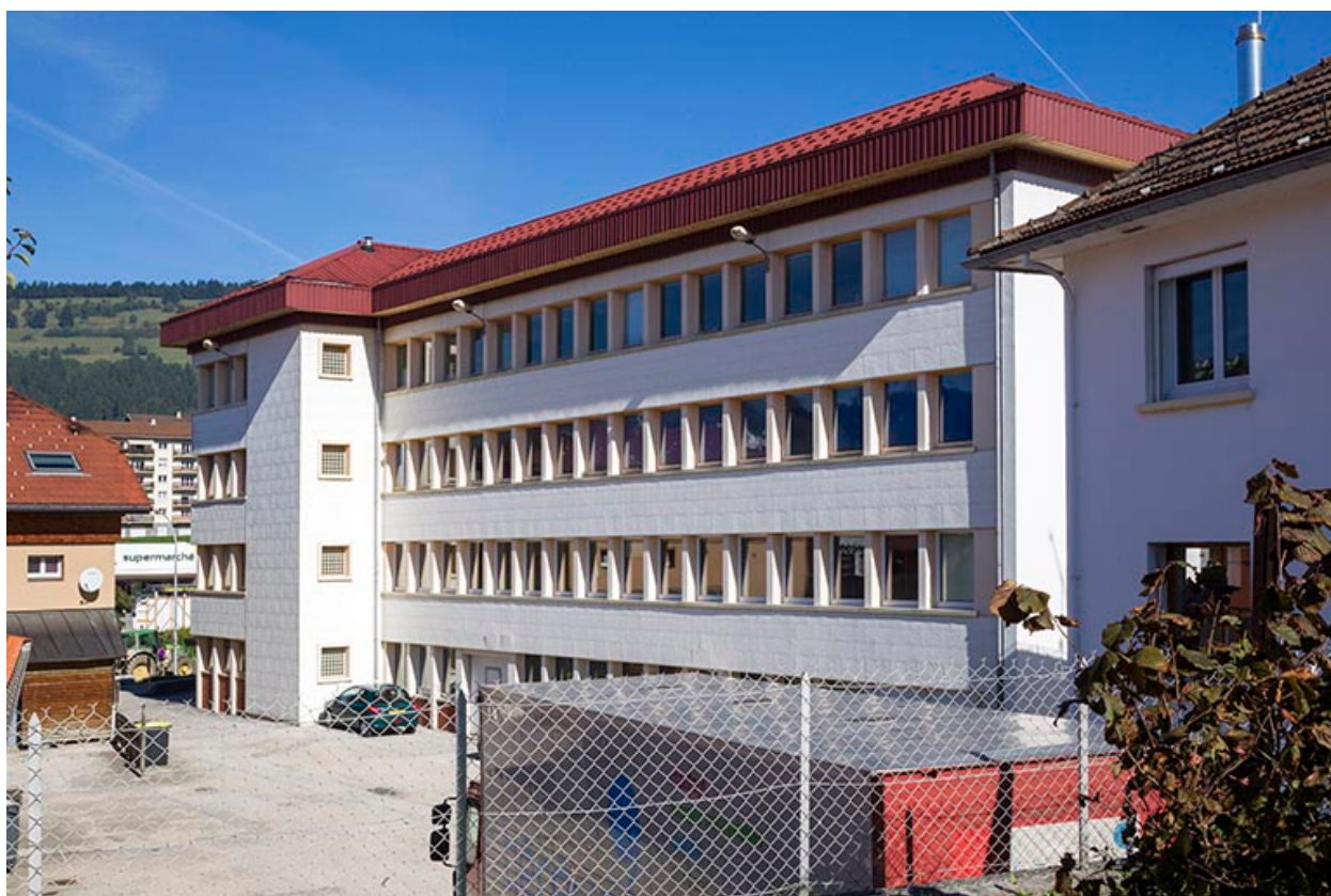
Usine : façade latérale droite, vue en enfilade.
