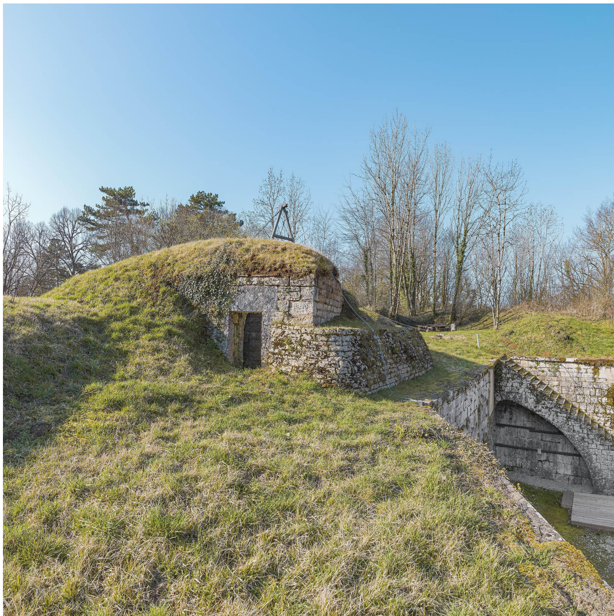
La casemate située sur le toit.
