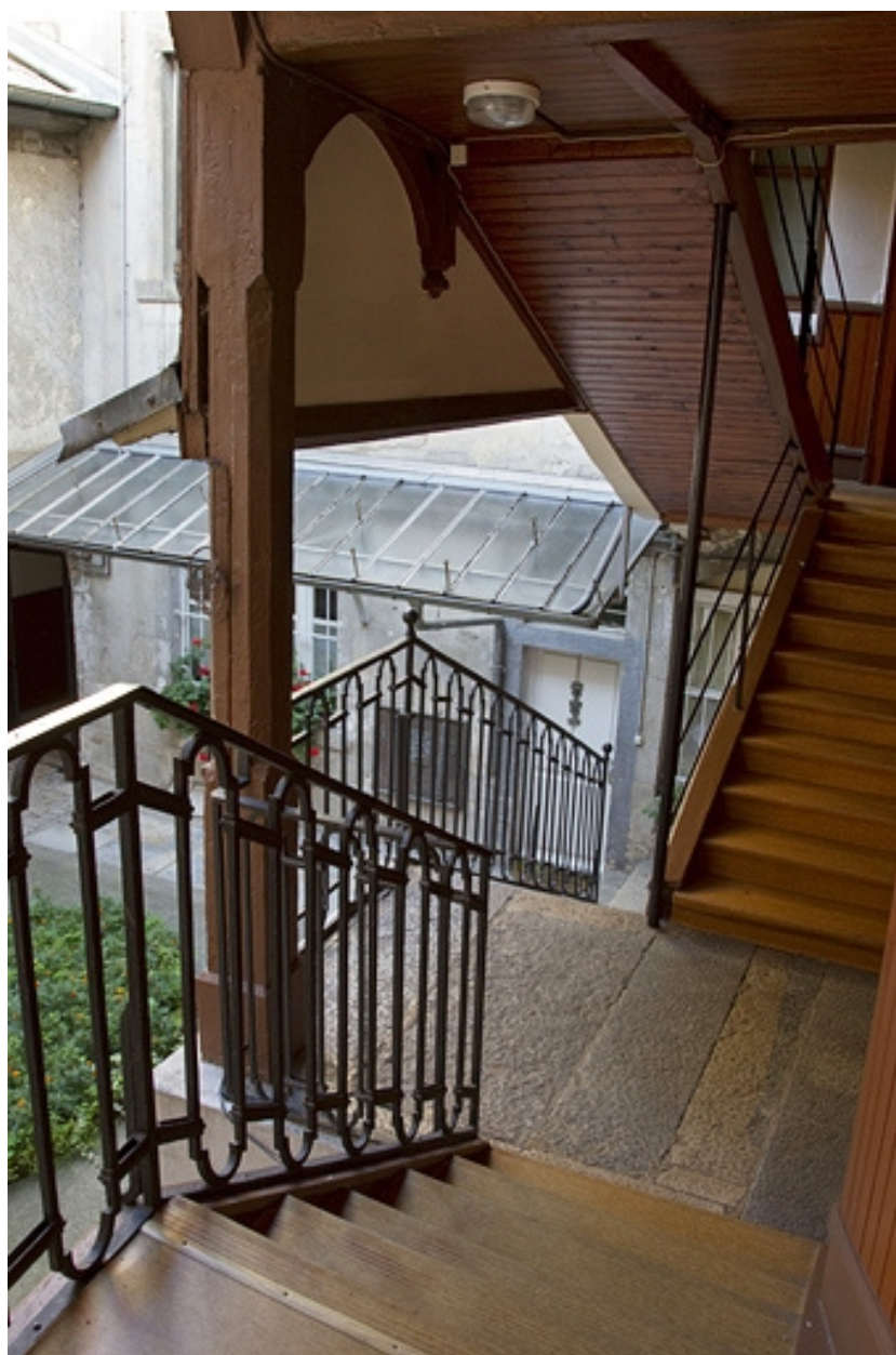
Escalier à cage ouverte : vue depuis l'intérieur.
