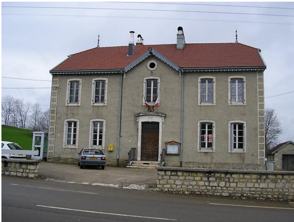
Vue générale de la façade antérieure.
