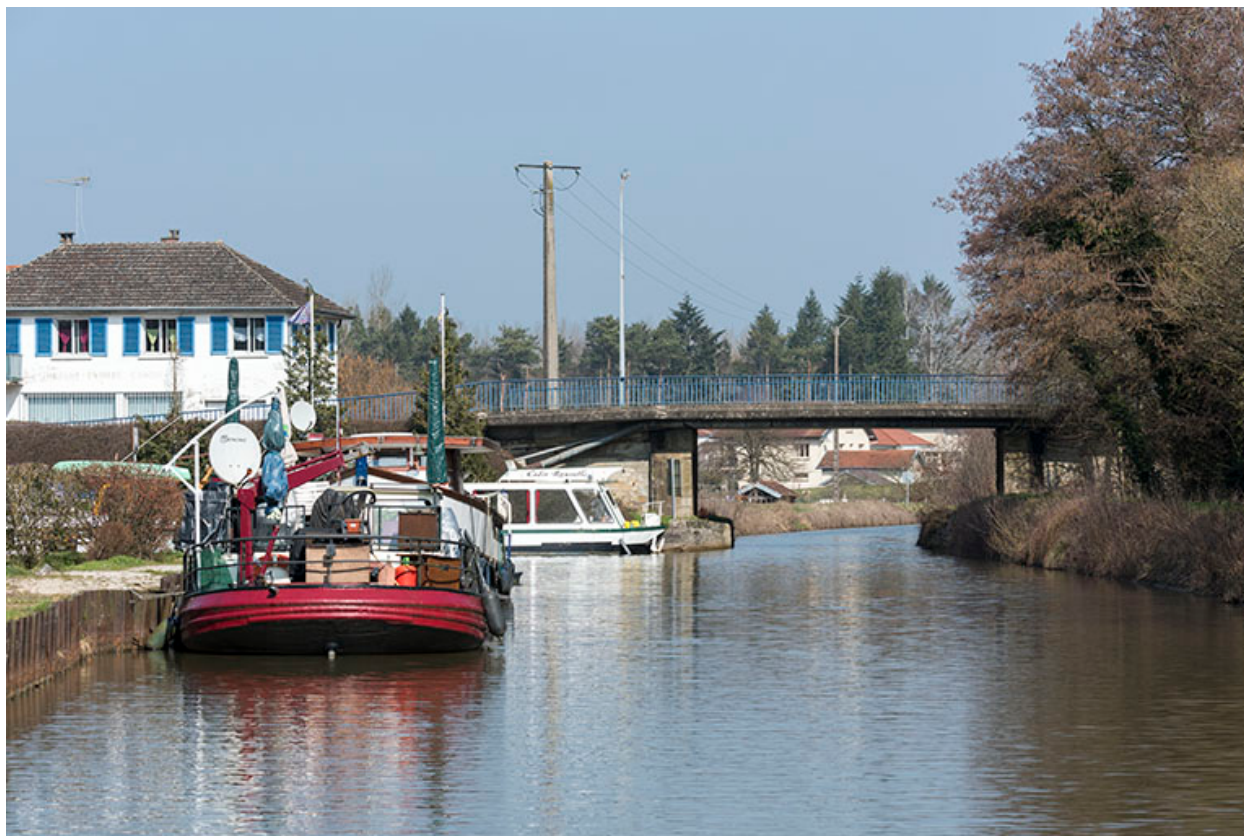
Pont sur le canal, vu de l'aval.
